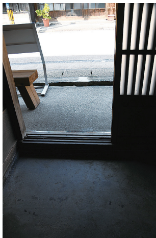
館内入口内側下り段差有り
