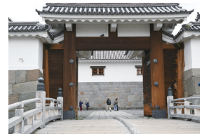
東御門橋は路面が木製の太鼓橋
